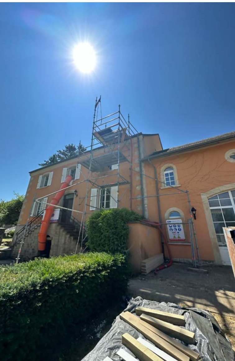
Projet de rénovation à Clemency
